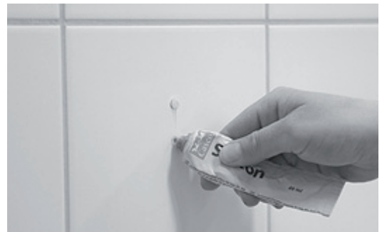
[ Bild 4.] VIKTIGT! Våtrumssilikon i pluggen och runt hålet.
